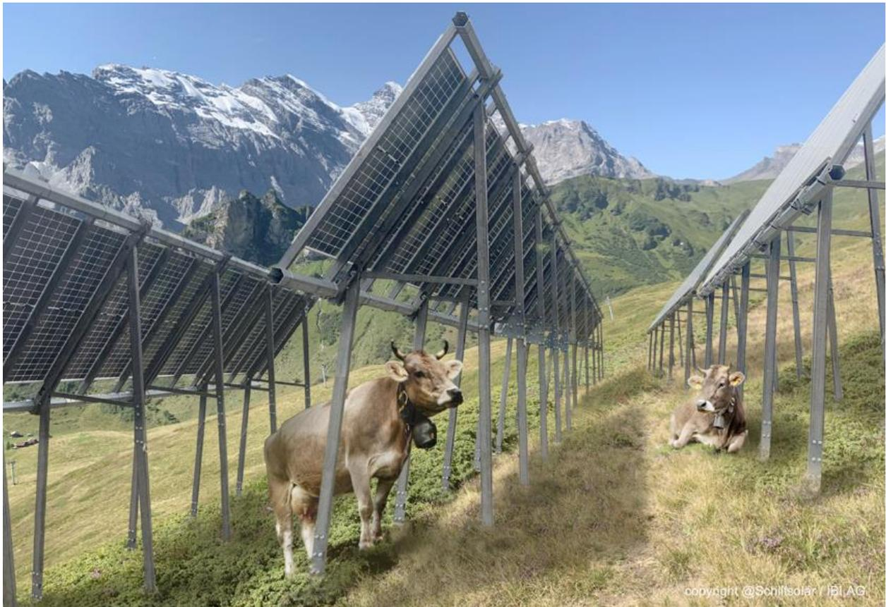
Bild: Mit der geplanten Anlage wird eine Doppelnutzung aus Alpwirtschaft und Stromerzeugung ermöglicht. Die Solartische haben einen Reihenabstand von rund 4.5 Metern. Der Abstand vom Boden bis zur Unterkante der Solarmodule beträgt mindestens 2.5 Meter. Somit können sich Tiere frei durch die Anlage bewegen.
