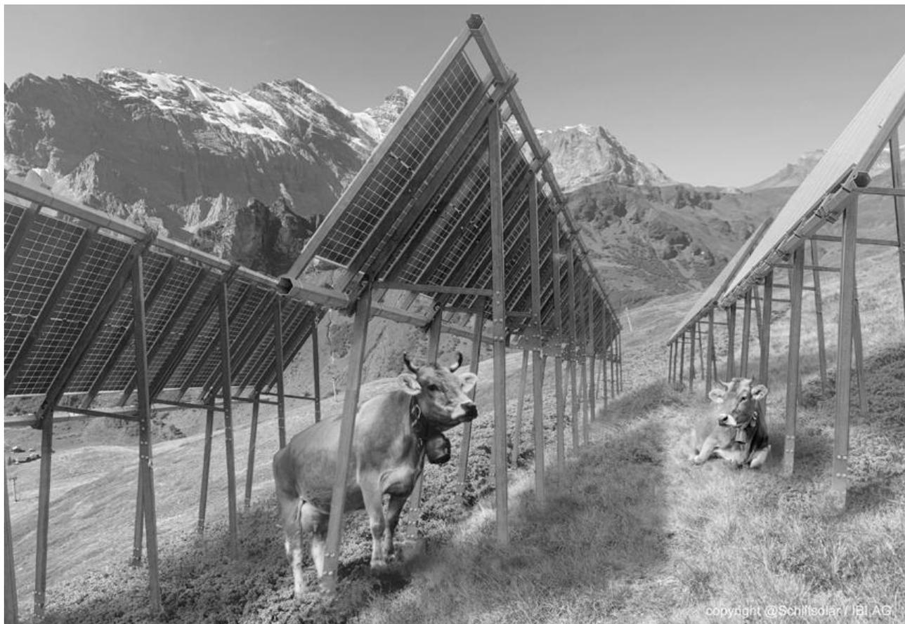
Bild: Mit der geplanten Anlage wird eine Doppelnutzung aus Alpwirtschaft und Stromerzeugung ermöglicht. Die Solartische haben einen Reihenabstand von rund 4.5 Metern. Der Abstand vom Boden bis zur Unterkante der Solarmodule beträgt mindestens 2.5 Meter. Damit können sich Tiere frei durch die Anlage bewegen.
